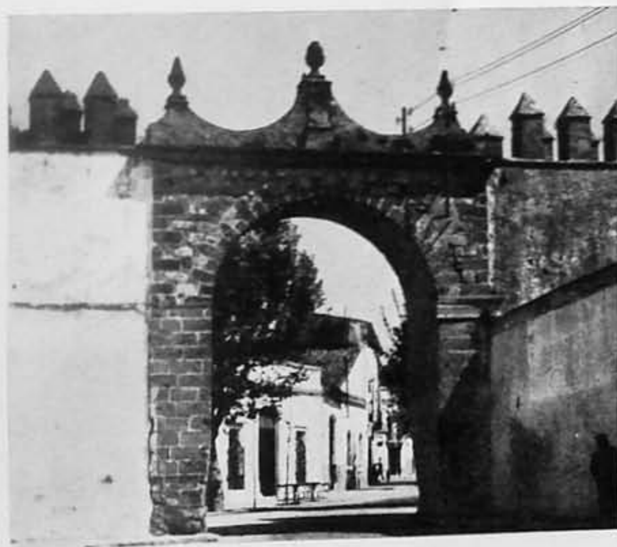
Puerta del Arroyo, desde el exterior.
